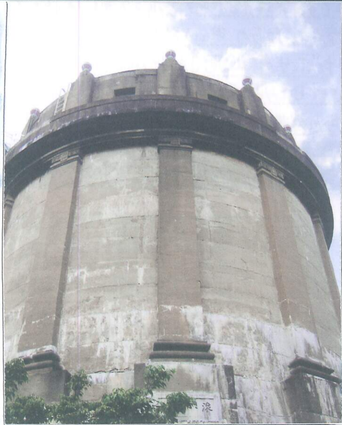
▲高さ約30mもある駒沢給水塔(2号塔)
